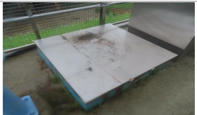
배수지 덮개 상태양호
