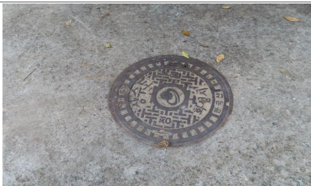
유량계실 덮개 상태양호
