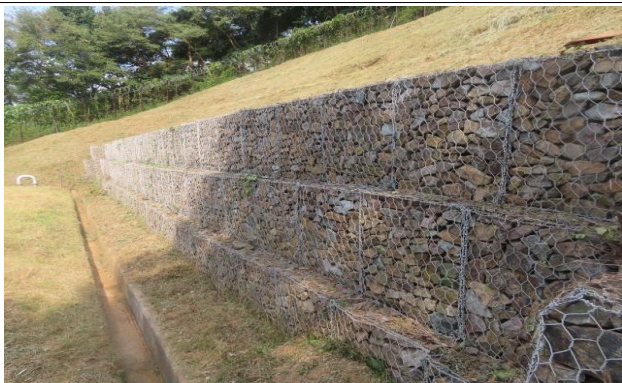
계비온 옹벽 상태양호
