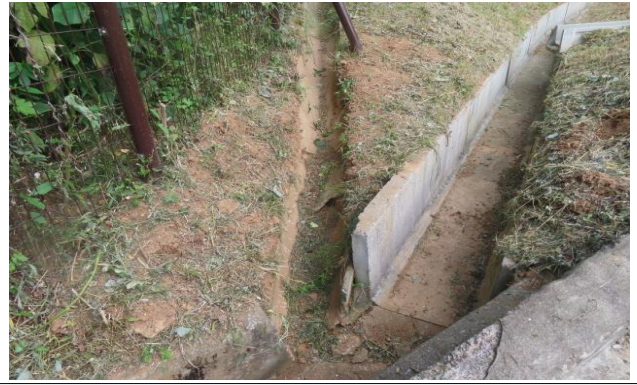
기타 부대시설 배수로 이물질퇴적 보수완료
