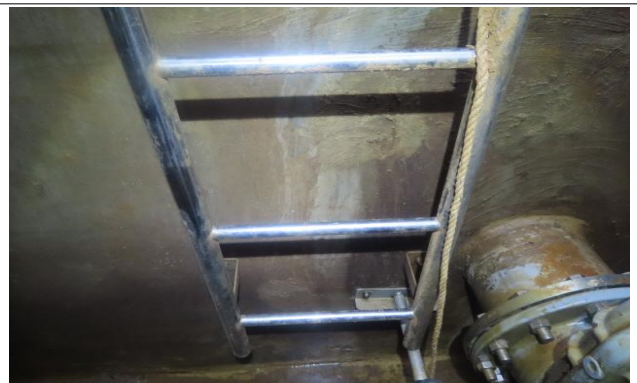
유입밸브실 사다리 상태양호
