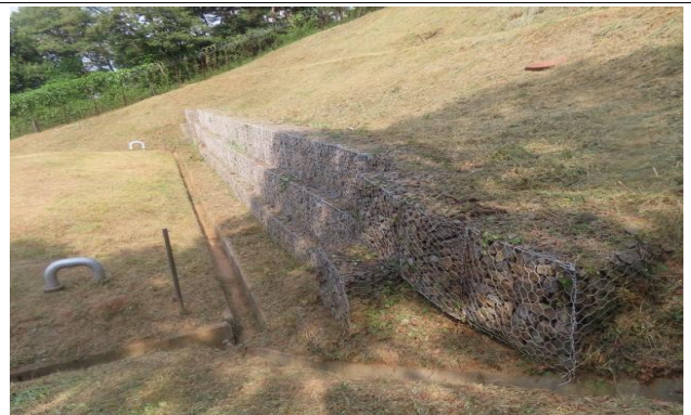
계비온 옹벽 상태양호
