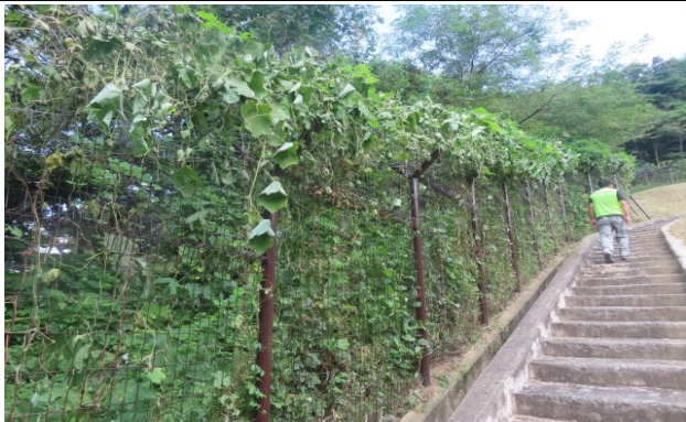
기타 부대시설 펜스 상태양호
