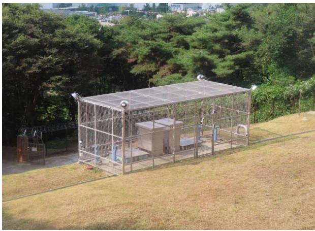
배수지 외부 전경
