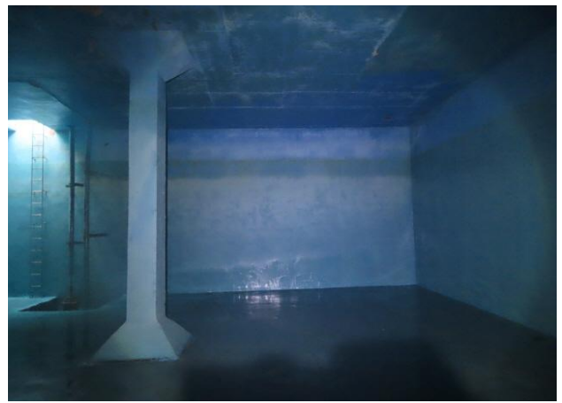
배수지 내부 전경
