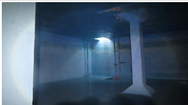
배수지 1지 내부 전경
